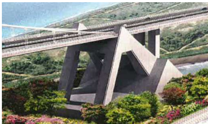
Figur2.3: Tilsvarende forankringskloss foreslått på Izmit (bru i Tyrkia)
